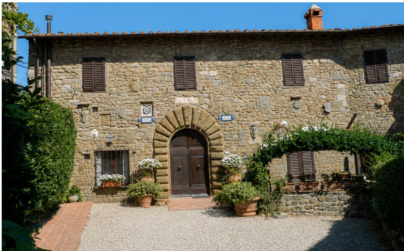
Figure 13 Palazzo del Podestà
