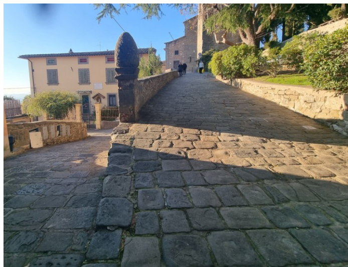
Figure 14 rampa di accesso alla Chiesa di San Pietro Apostolo e sulla sinistra abitazione dove visse il poeta Diuseppe Giusti
